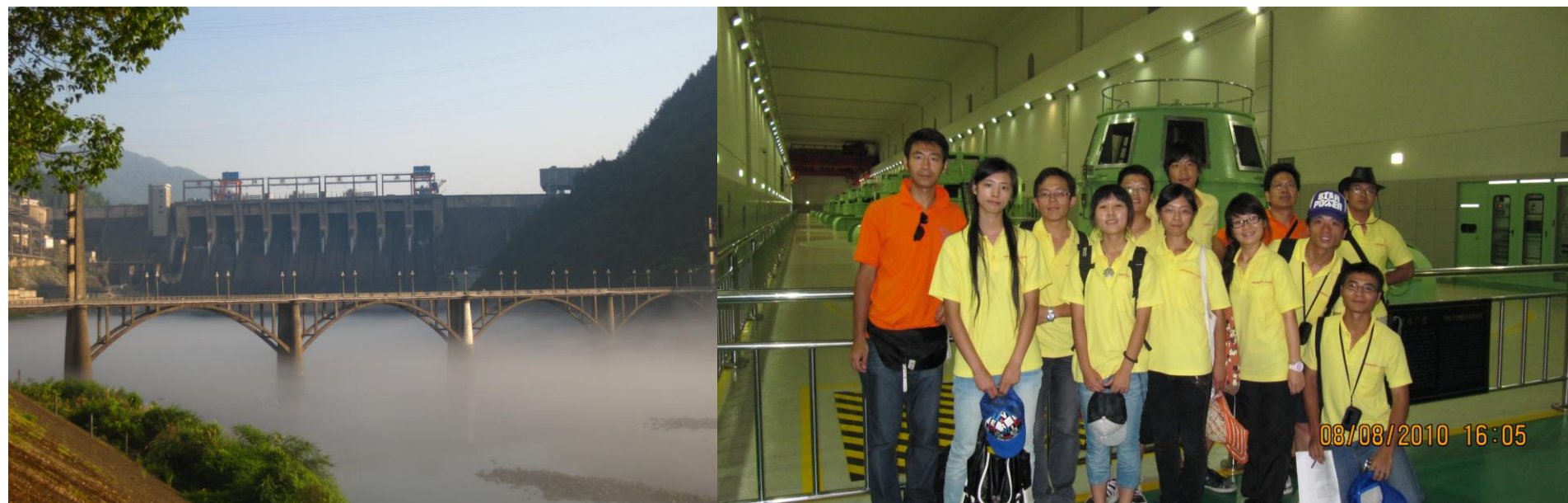
新安江水电站全景图：全国第一座水电站——新安江水电站，装机9台，总容量66.25万千瓦，设计年均发电量18.6亿千瓦时；大坝全长466.5 m，坝高105 m，设计正常高水位108 m，相应库容178.4亿 \text{m}^3 ，为多年调节水库，可防御万年一遇洪水，浩瀚的水库环绕丛丛山岭，形成了蜚声中外的绿色“千岛湖”。
